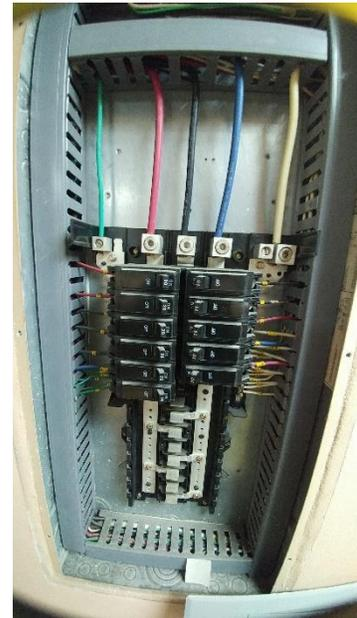
Los dispositivos de protección de los circuitos serán del tipo termo magnético y serán para 60 ciclos y de las capacidades indicadas en los planos.
